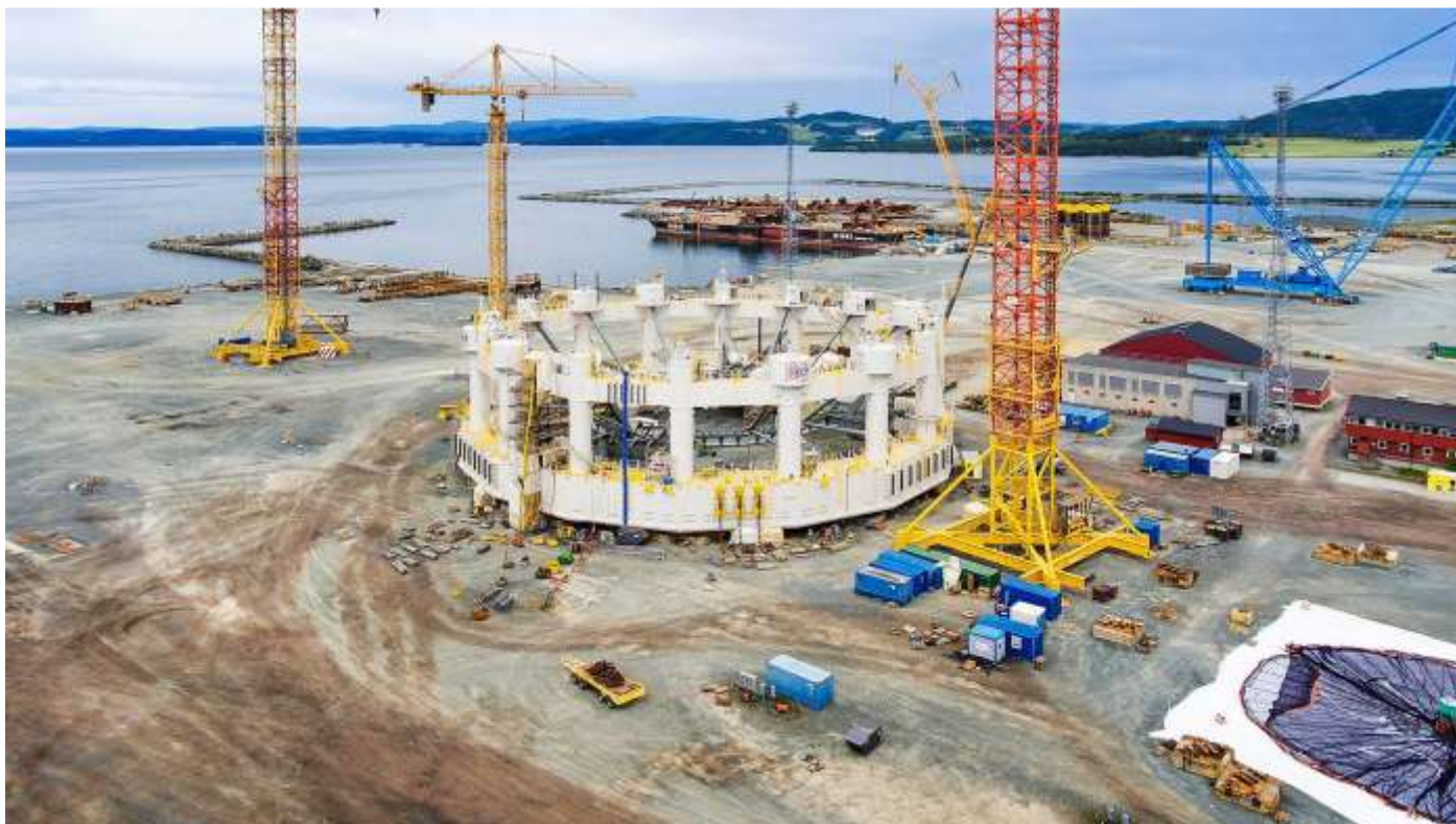
Figur 10: Utrusting av merd ved verft på Verdal.
